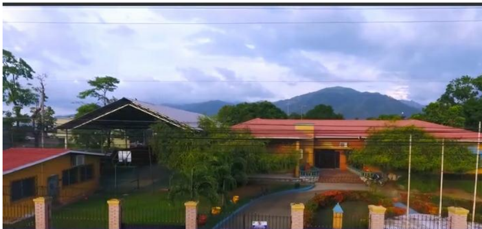
Instalaciones de Discovery School en el Progreso, Yoro.
