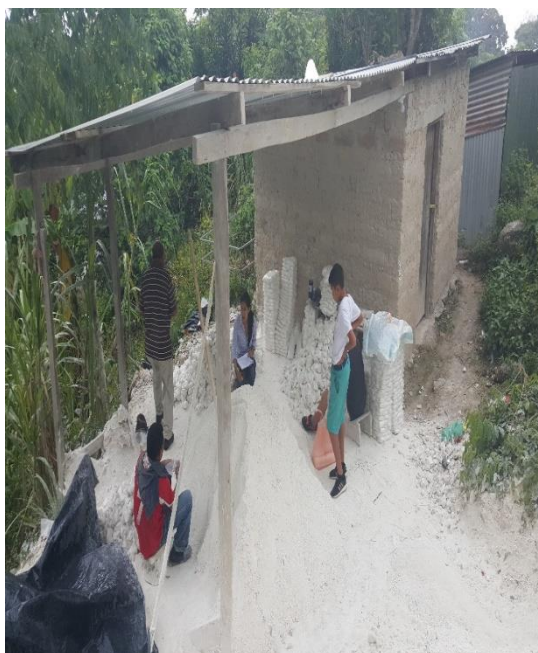
Figura 11. Plantel alejado de las viviendas
